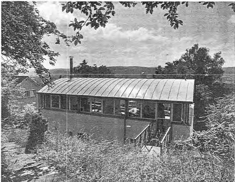
Transparent ist der im zweiten Stock thronende Wohn-Großraum unterm Tonnendach vom Garten aus. Das Dach ist übrigens sehr gut isoliert, die Süd Fenster bringen passive Solarwärme ein, sodaß man selbst im Winter nach Beobachtung der Bewohner auf Niedrigenergiewerte kommt.
